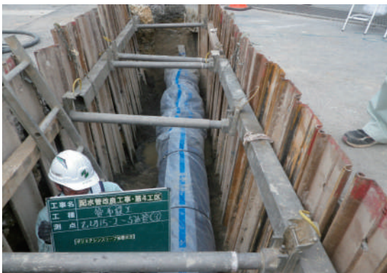
配水管改良工事
