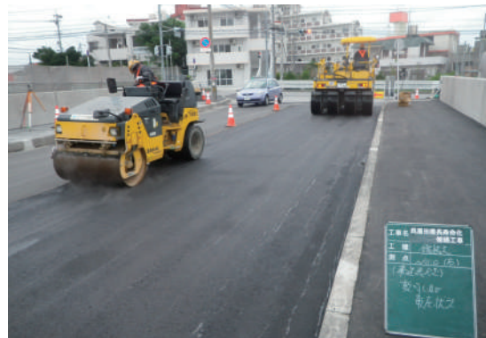
呉屋田橋長寿命化修繕工事
