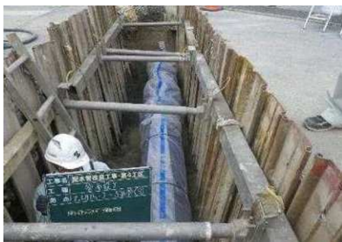
配水管改良工事
