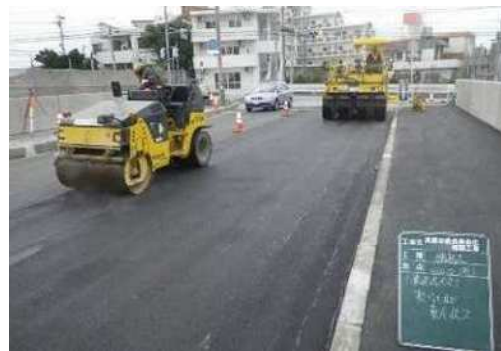
呉屋田橋長寿命化修繕工事
