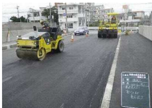
呉屋田橋長寿命化修繕工事
