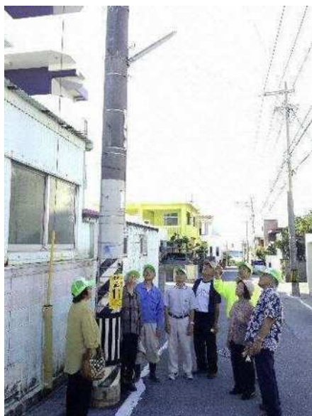
防犯灯の点検（宇地泊区）
