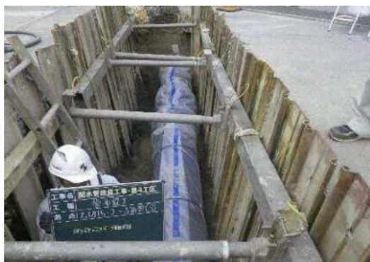
配水管改良工事
