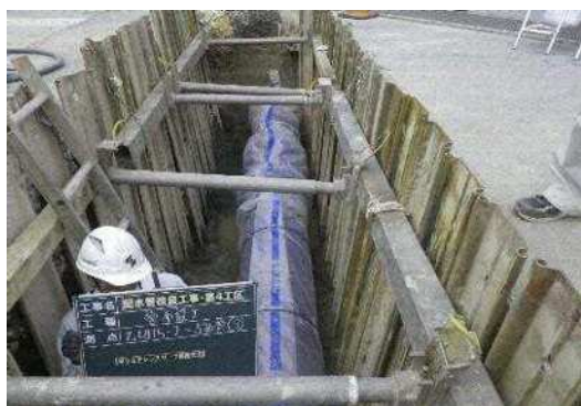
配水管改良工事
