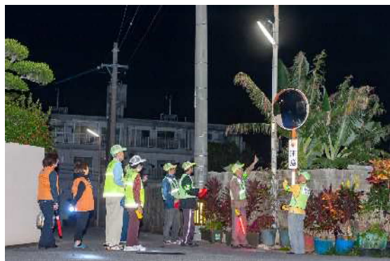
防犯灯の点検
