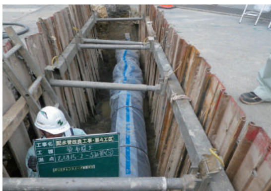
配水管改良工事
