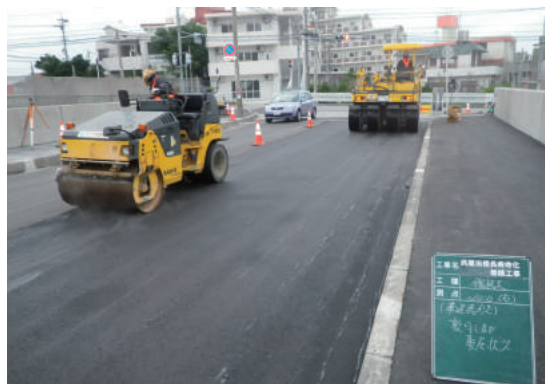
呉屋田橋長寿命化修繕工事
