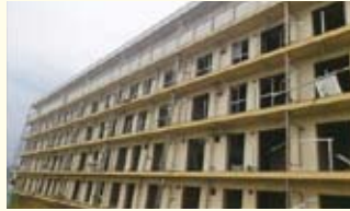
▶4階まで津波に遭った公営住宅
