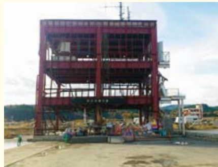
▲南三陸町防災対策庁舎
