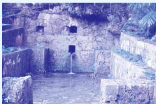
▲我如古ヒージャーガー 降り口には現在、手すり付きの階段が設置され、当時の人々の利用の様子が描かれた案内板もあります。
