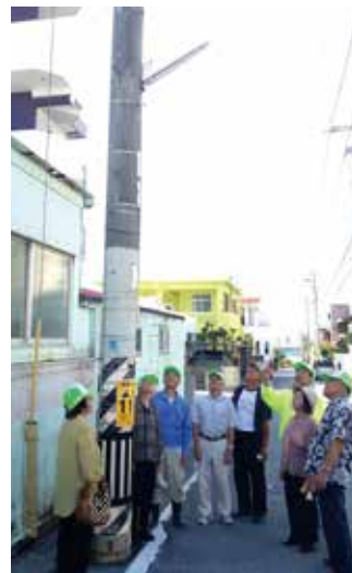
暗い夜道を照らす防犯灯の定期点検
