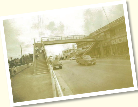
▲宜野湾小学校前の歩道橋 1975(昭和50)年頃
