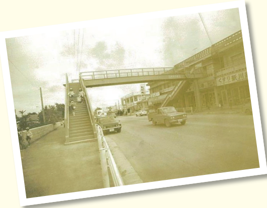
▲宜野湾小学校前の歩道橋 1975(昭和50)年頃
