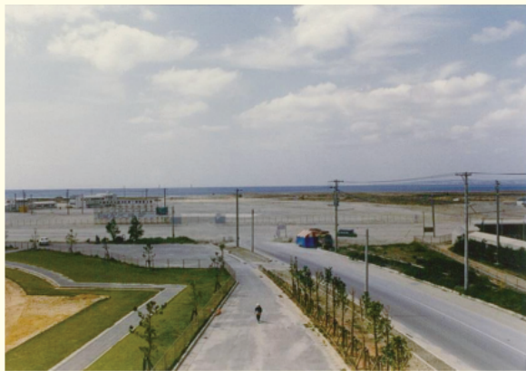
▲沖縄コンベンションセンター建設前の様子1985（昭和60）年頃
