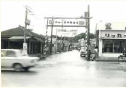
▲ニュー普天間通り 1966(昭和41)年 この年に舗装工事が竣工しました
