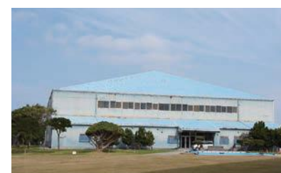
▲今後、解体が予定されている屋内運動場
