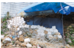
修復工事の様子
