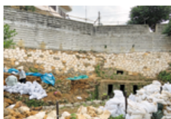
修復工事の様子
