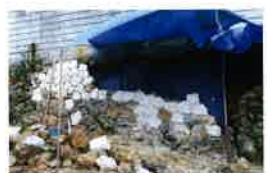
修復工事の様子
