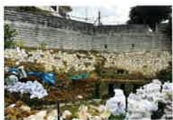
修復工事の様子
