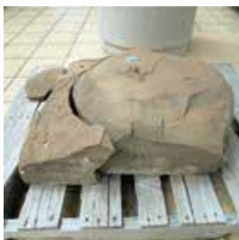
写真② 首里城の「礎石（そせき）」。火災によって変色やひび割れが生じています。
