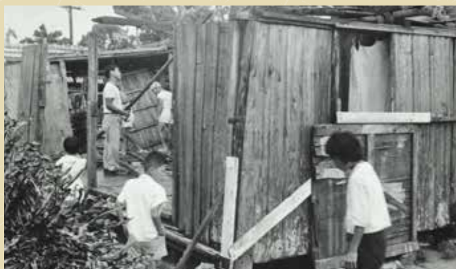
▲台風ティルダが上陸し、家屋が半壊している様子 1961（昭和36）年 宜野湾村内
