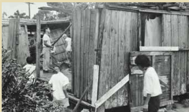
▲台風ティルダが上陸し、家屋が半壊している様子 1961（昭和36）年 宜野湾村内
