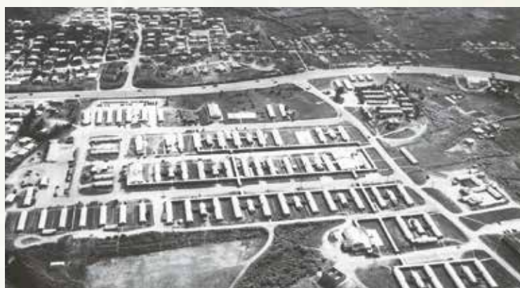
▲(写真①)左右に横断する軍道1号線と多くのコンセットが立ち並び、キャンプ・マーシー(軍道と縦に伸びる道の交差点は今のトーエ付近) 1960(昭和35)年頃
