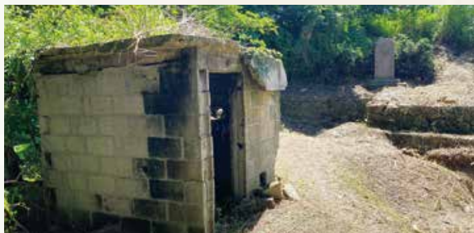
▲普天間飛行場内に残るポンプ小屋跡(手前)と字宜野湾の産泉(奥)。ポンプで産泉から貯水タンクへ水を送っていた。
