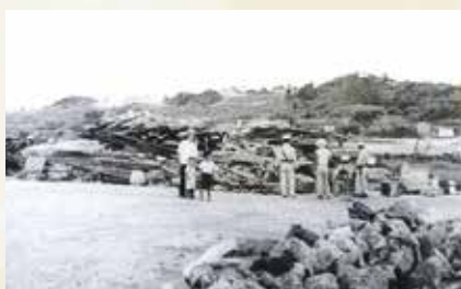
◀ブルドーザーに押しつぶされた家（伊佐浜） 1955（昭和30）年
