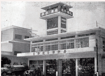
■昭和38年3月 消防庁舎落成
