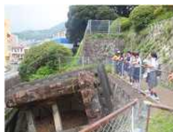
▲重さ 50 t の鐘楼が 35m も吹き飛ばされた
