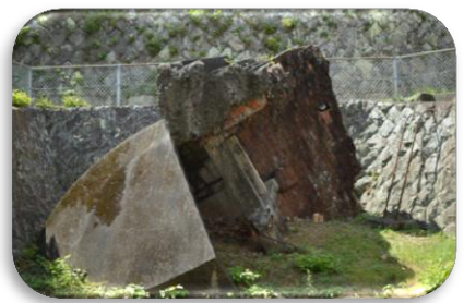
▲重さ 50 t の鐘楼が 35m も吹き飛ばされた
