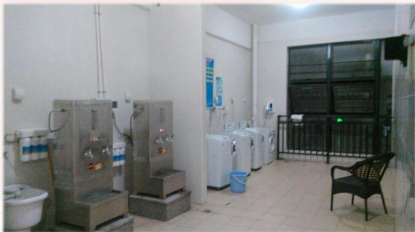
洗濯機と給湯器
