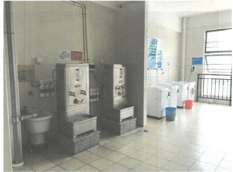
給湯器と洗濯機と乾燥機完備。給湯器は無料。
