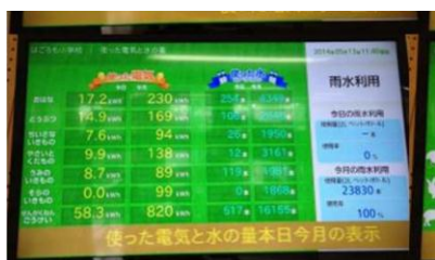
使用電力・水量監視装置
