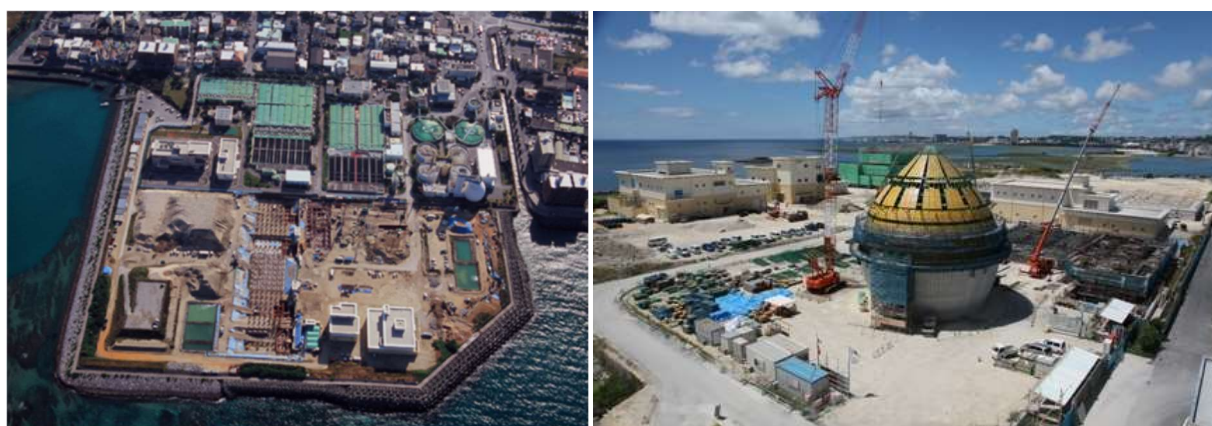
図 3-3 みずクリン宜野湾（宜野湾浄化センター）の外観
