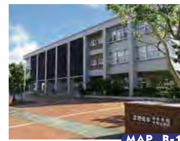
宜野灣市民會館（翻新工程進行中）
