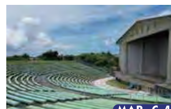
露天劇場（建設中）
