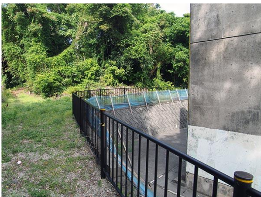
中学校との境界は間知ブロック積みがある
