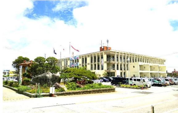
耐震改修した市役所庁舎
