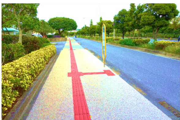
点字ブロックの設置
