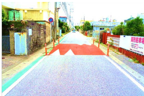
生活道路の安全対策（ハンプの設置）
