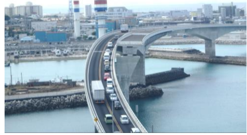
沖縄西海岸道路(浦添北道路)
