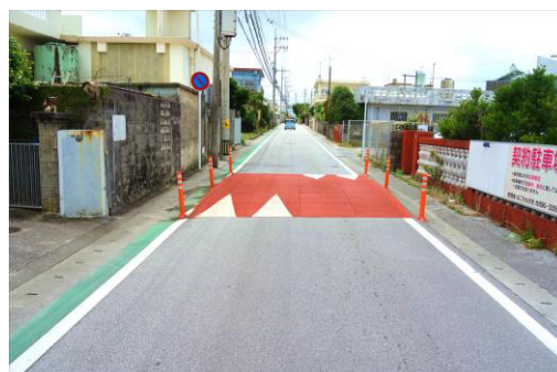
生活道路の安全対策(ハンプの設置)
