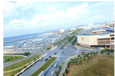
国道 58 号宜野湾バイパス沿道
