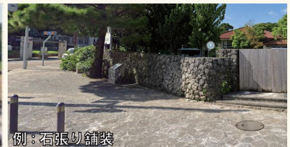
例：石張り舗装
