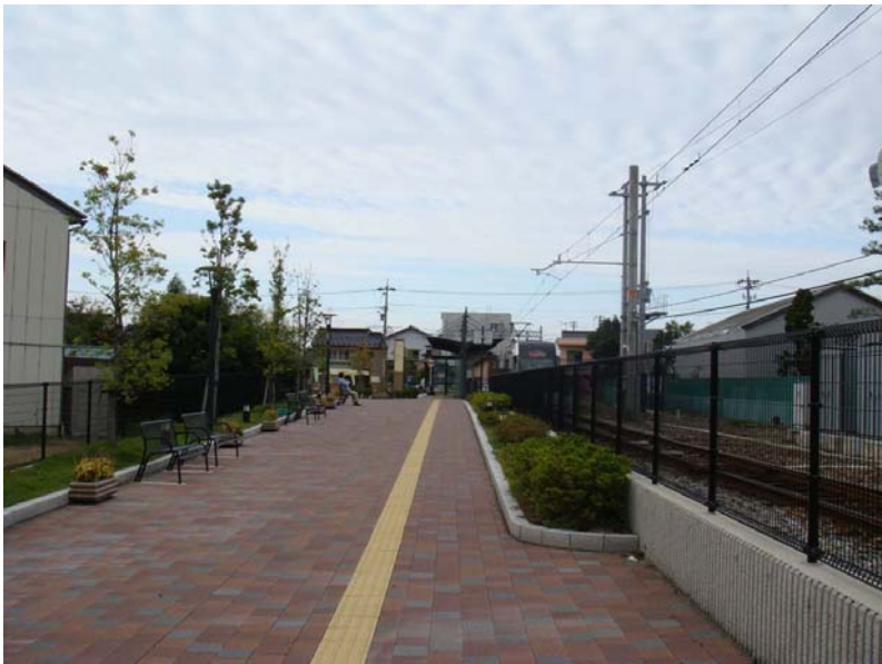
岩瀬浜電停周辺整備の様子
