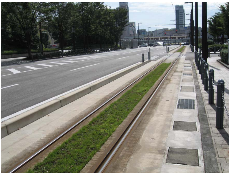
富山駅北付近の緑化された軌道
