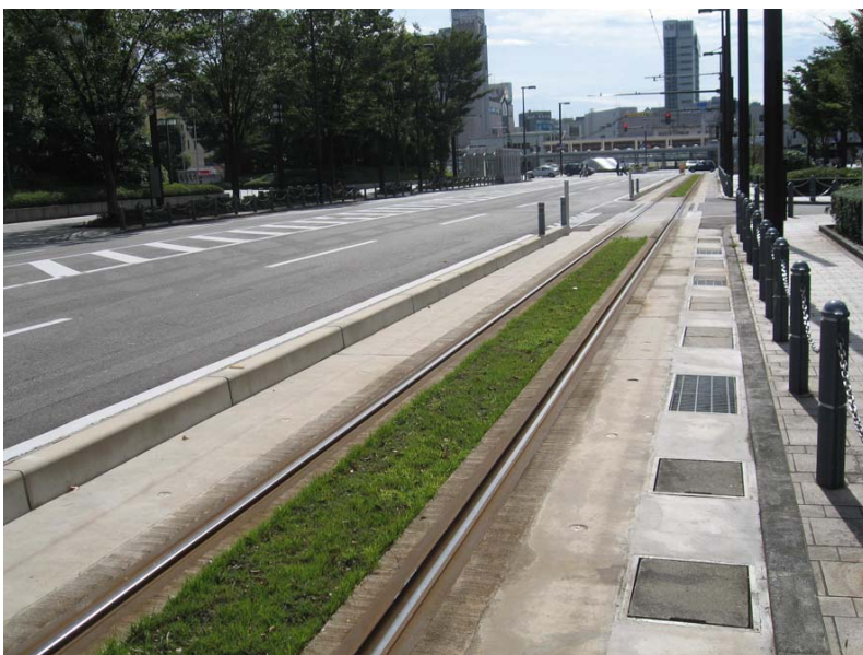
富山駅北付近の緑化された軌道
