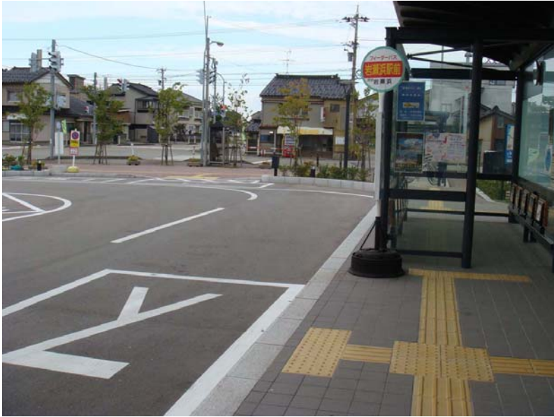
乗り継ぎがスムーズになるように電停のすぐ反対側がフィーダーバス乗り場となっている（岩瀬浜電停）
