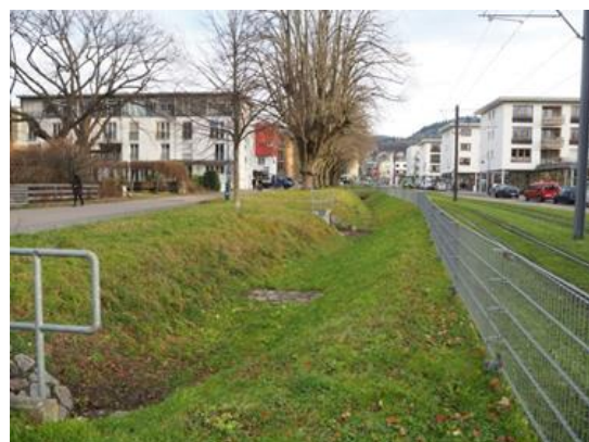
図Ⅶ-11 地区内の雨水流下の調整池
