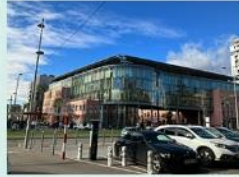
新設建築物の様子
