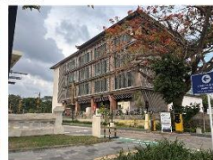
建設中の医療施設
