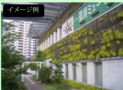
イメージ例 壁面の温熱環境を改善する効果のある壁面緑化 環境ミュージアム（北九州市）
