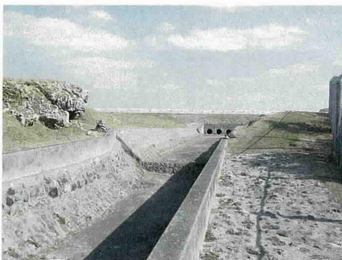
写真9：真栄原付近、普天間基地内から流出する水路 （ボックスカルバートにより真栄原十字路付近へ向かう） 資料 図1-11(3) 現地踏査写真
