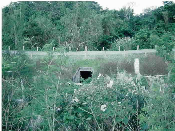
写真6：宜野湾市宜野湾にみられる基地内に流入する吸込口 資料 図 1- 11(2) 現地踏査写真
