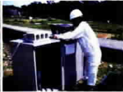
保護箱設置及び地下水位観測状況
