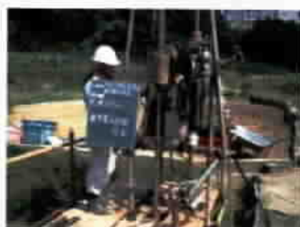
標準貫入試験状況
