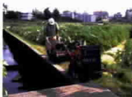
資材搬入状況
