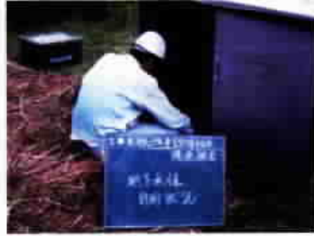
保護箱設置及び地下水位観測状況
