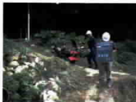
資材搬入状況
