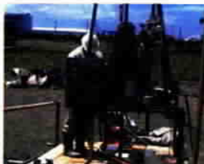
標準貫入試験状況
