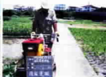
資材搬入状況
