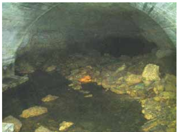
フルチンガー (マンホール内)
