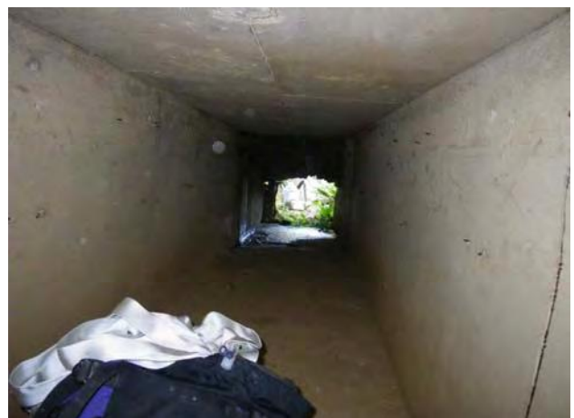
2011/2/1 P0500010.JPG 洞穴内水質・底質等概査 カンガー 調査箇所から外側の様子
