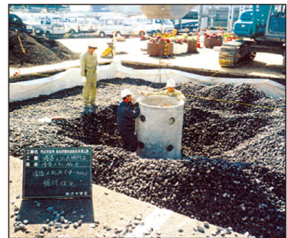
大型浸透ますの施工状況
