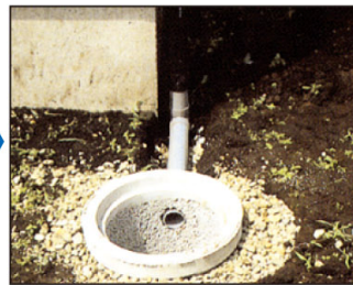
浸透ますの施工状況
