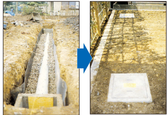
浸透トレンチの施工状況
