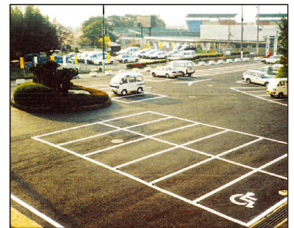
完成した透水性舗装
