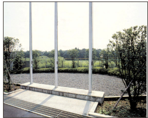
浸透池の全景
