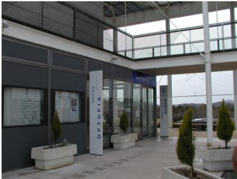
播磨科学公園都市内に立地する生活利便施設「光都プラザ（地区センター）」
