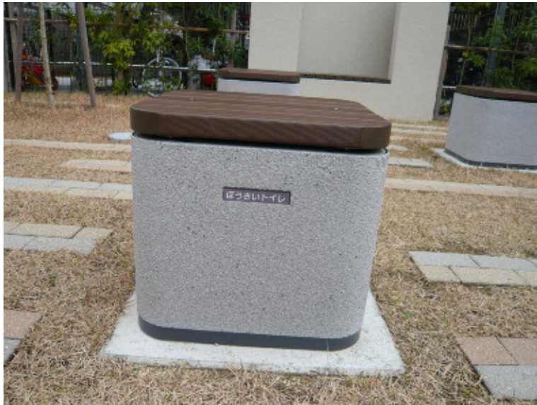
休憩スペースのベンチは災害時に使用できる防災トイレとなっている
