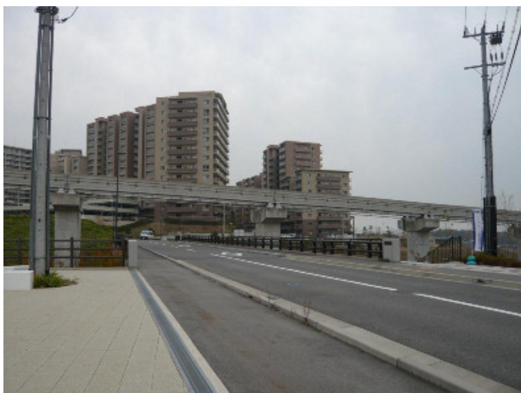
彩都内を走る大阪モノレール彩都線の高架橋
