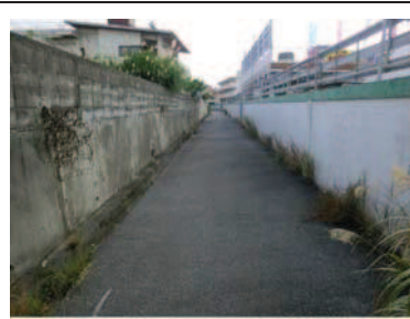
写真 1-14 谷底低地の暗渠と両側の盛土（上流を見る） 右：県道部の盛土状況（下流を見る）
