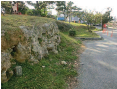
写真 1-9 普天間飛行場入口に露出する琉球石灰岩 凹凸が激しく、小さな空洞が見られる
