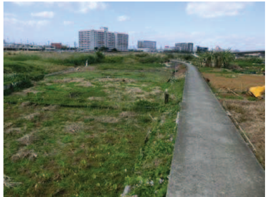
写真 2-16 大山湿地に延びる水路（暗渠） この水路は上流の沢水から供給されている
