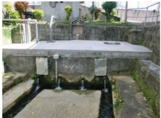
写真 2-18 伊佐 2 丁目国道下の湧水 取水設備より多量の湧水がある
