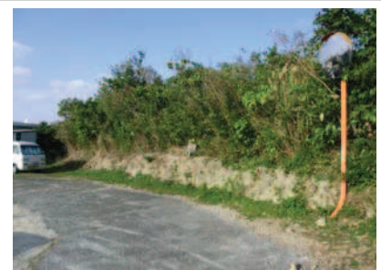
写真 1-6 普天間飛行場境界の石灰岩丘の露頭 岩丘斜面に凹凸のある石灰岩が見られる
