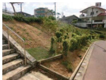
写真 1-11 公園の東切土面に露出する洪積粘性土（島尻マージ） 多数の石灰岩礫を含む粘性土
