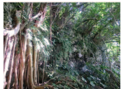
写真 1-2 森川公園の洞穴（拝所）付近の斜面状況
