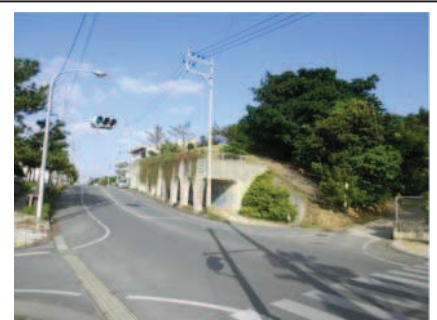
写真 1-1 森川公園入口左の岩丘 前面道路は石灰岩丘を切土して造られている。
