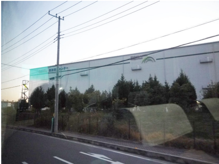
流通ゾーンに立地する倉庫
