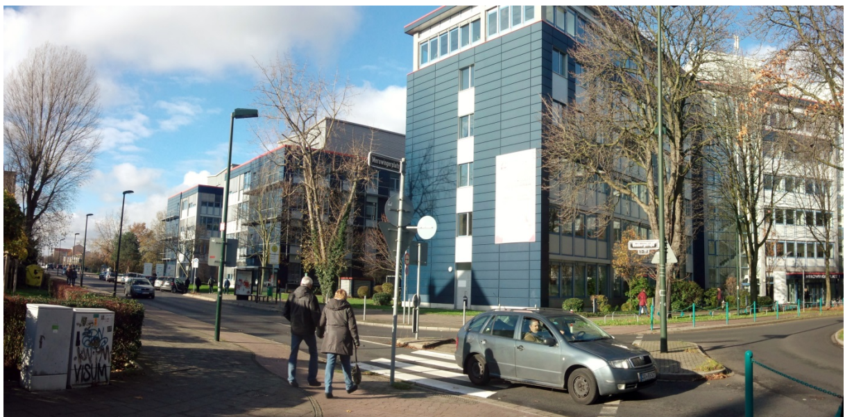
緑豊かな市街地の中に立地するライフサイエンスセンターの施設群
