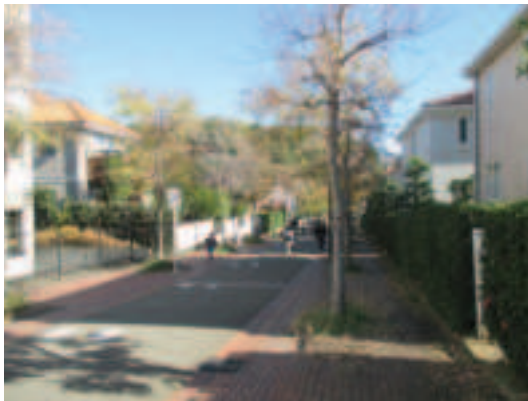
住宅地内の歩行者専用道路
